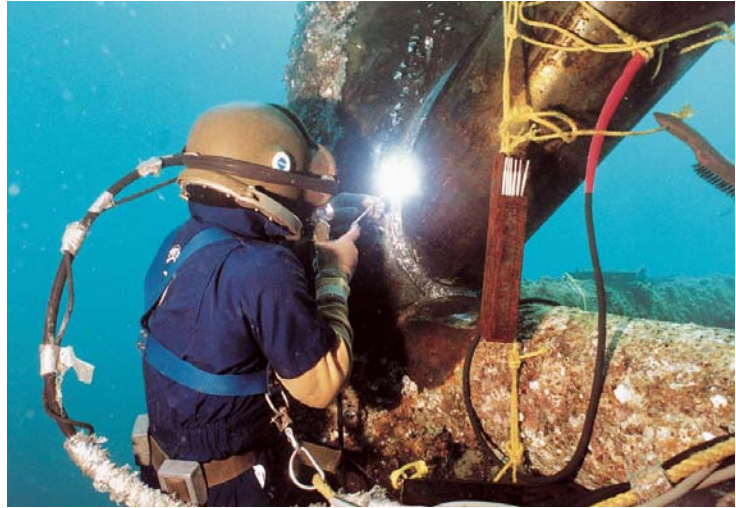
Сл. II.5. Рачно електролачно заварување под вода
