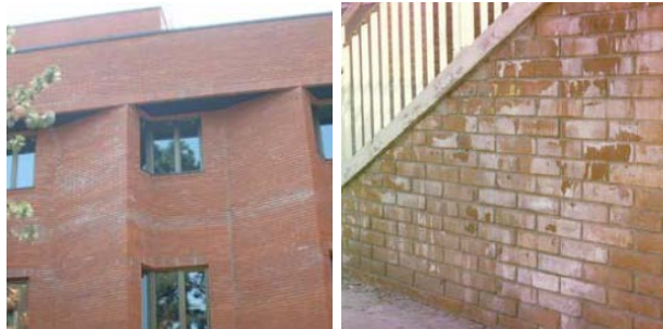
Слика 7-3 Облици на корозија како резултат на а) спречено и б) непречено ширење [10]
