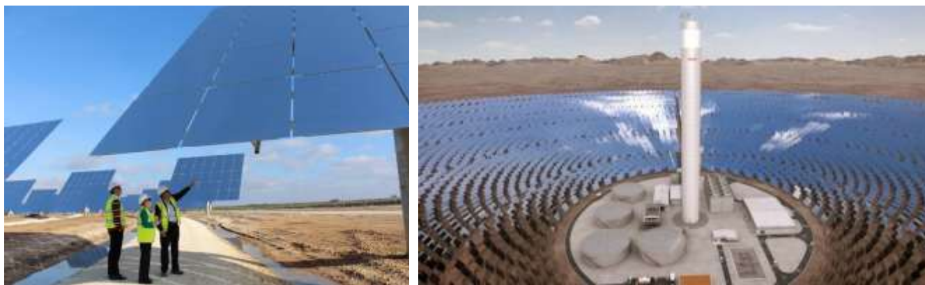
Слика 1.7: Приказ на дел од хелиостатите во соларна електрана со централен приемник ( eng. Concentrated Solar Power-CSP plant ) - Атакама 2 со инсталирана моќност 110 MW, [2, 3]
